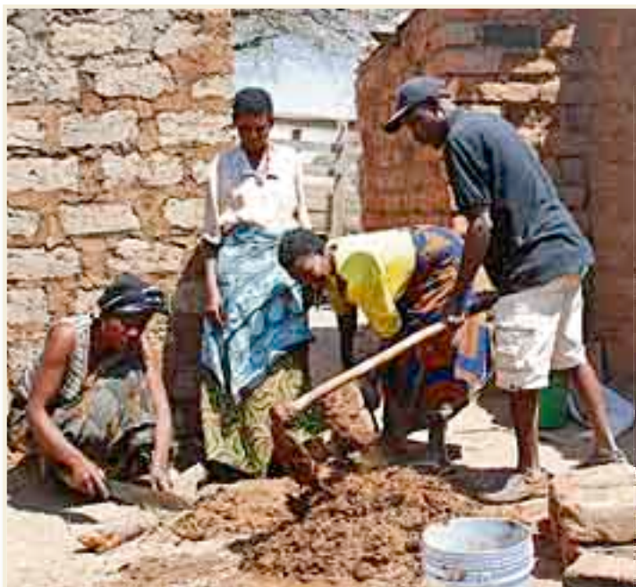
Fasi di preparazione per la costruzione del forno.
