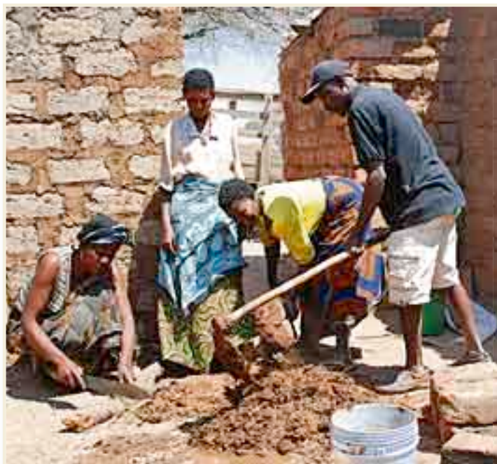
Aus Erde, Wasser, Gras und Holzspänen wird der Mörtel für den Ofen hergestellt.
