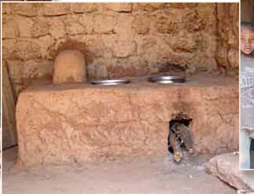
Der fertige Ofen mit Feuerraum (vorne) und dem Ofenrohr (links), das den Rauch nach aussen führt.
